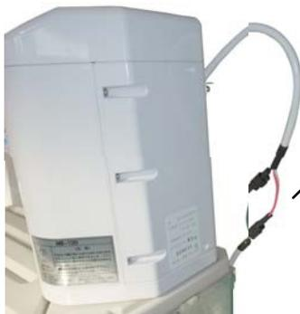
2.本体裏側の配線コードからカバーをはずしますと、図のように防水コネクタが2個出てきます。
